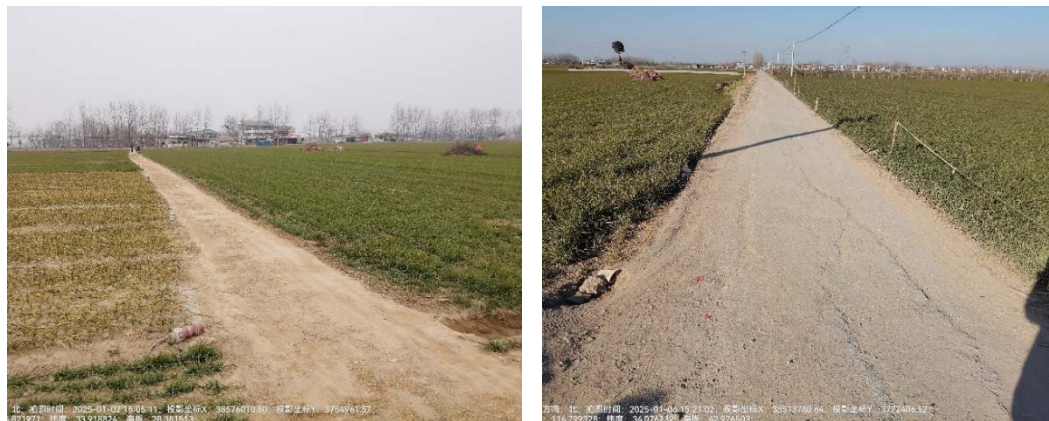
图 2-3 项目区现状道路
