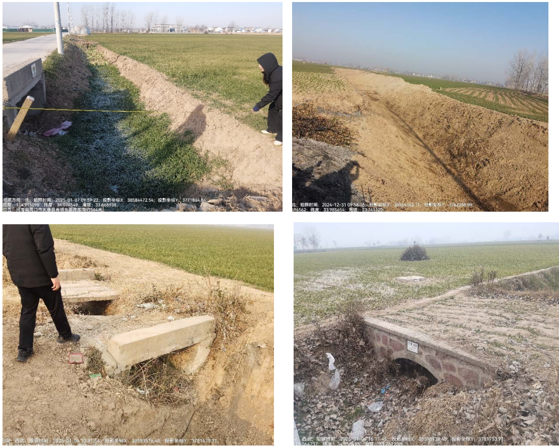
图 2-2 项目区排涝沟渠、桥涵
