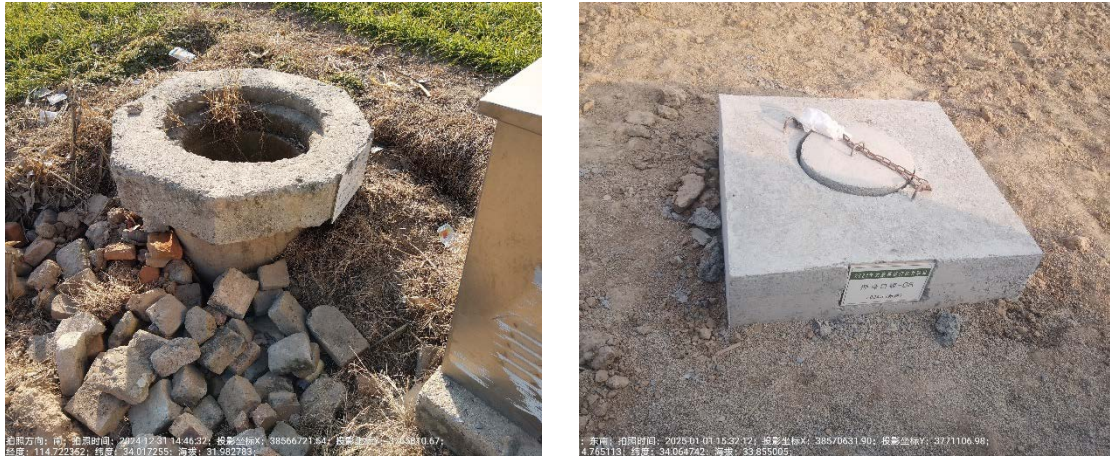
图 2-1 项目区现状机井
