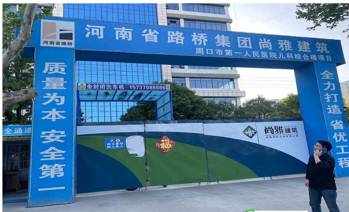
附件六：实地勘察照片
